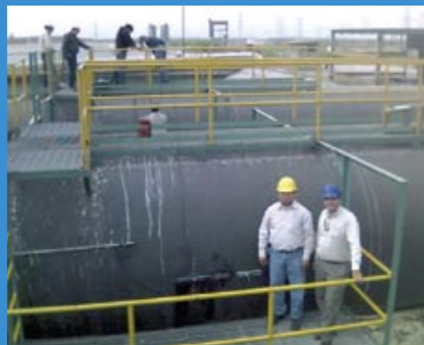
Installation på Ø 2600 mm rør med kølevand.
